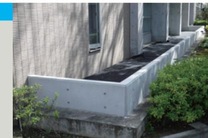
新たに設置した止水壁(2号館 北東ドライエリア)
